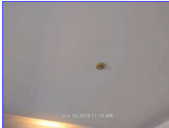
รูปที่ 2.37 อุปกรณ์ตรวจจับควัน
